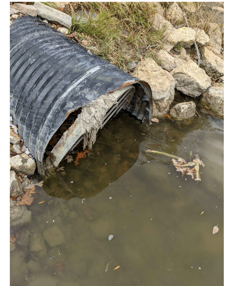
PIPE OUTLET DATE 2020-10
